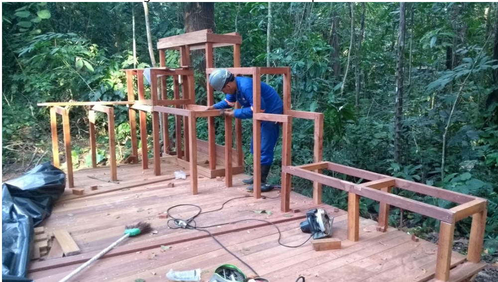
Imagem 03: Estrutura da Arquibancada.
