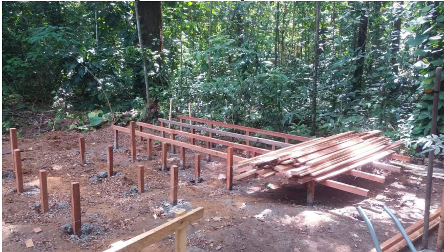
Imagem 02: Fundação e Gabarito.
